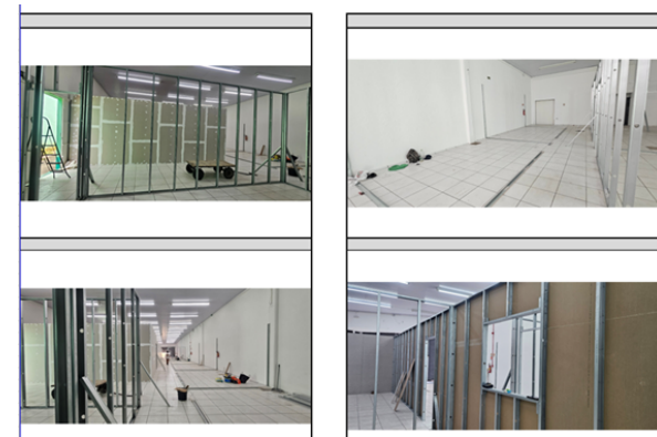
Obras de serviços comuns de engenharia Fonte: Arquivos da Gerência Administrativa do HU-Furg.
